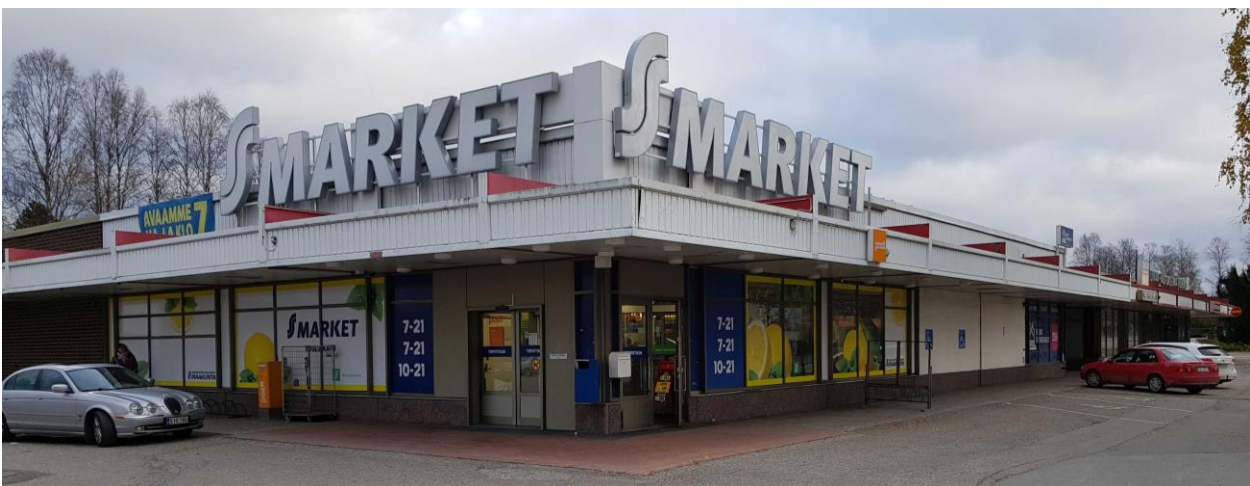
Kuva 59. S-marketin pääsisäänkäynti sijaitsee rakennuksen kulmassa. Sitä korostavat katokseen upotetut valaisimet. Katokset on myöhemmin maalattu valkoisiksi. Kookas ketjuliikkeen valomainos on korostetun suuri eikä sovi rakennukseen parhaalla mahdollisella tavalla.
