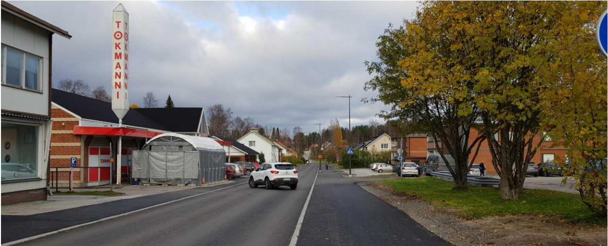
Kuva 33. Näkymä Rajakatua pitkin koillisen suuntaan. Rajakadun varressa Koulukadun risteuksen tuntumassa on kaksi liikerakennusta. Niitä viistosti vastapäätä on kaksi kaksikerroksista asuinkerrostaloa. Niiden koillispuolella Rajakatua reunustavat pääasiassa jälleerakennuskaudella valmistuneet pientalot. Rajakadun luonne muuttuu Koulukadulta koilliseen suuntaan edettäessä keskustaluken kauppakadusta asuntokaduksi.
