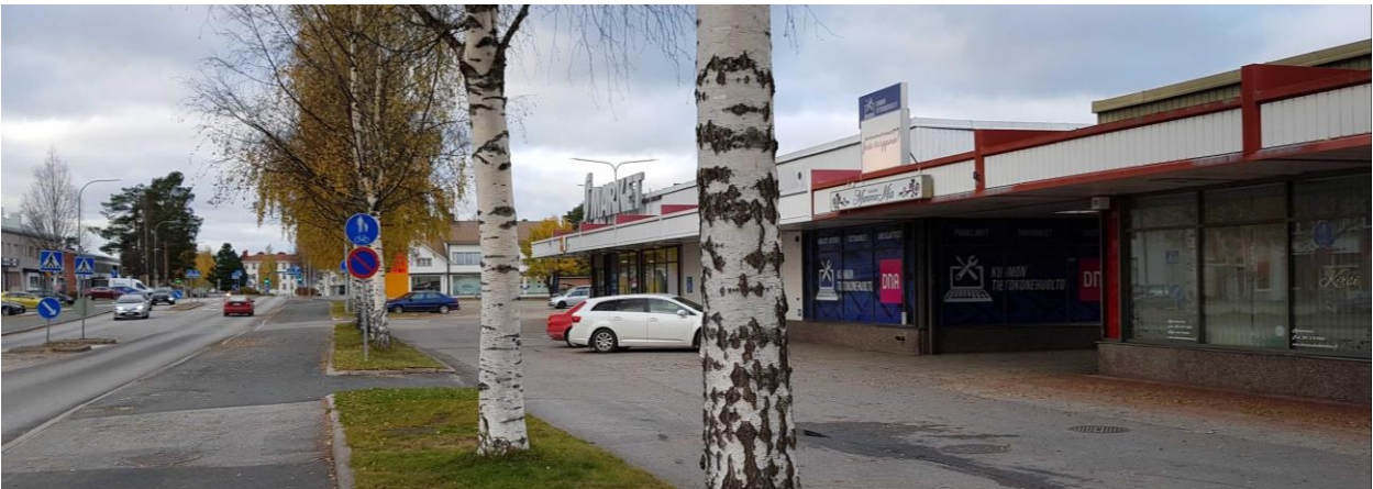
Kuva 56. Rakennuksen ulkoasuun on vaikuttanut julkisivuväriytyksen muutos: katosten alun perin punaiset palkit ja reunalistat on maalattu päivittäistavara-kaupan puolella valkoisiksi. Alkuperäinen väriytyksen säilynyt paremmin linja-autoaseman puolella. Katoksen pellitetty pystypinta on mahdollisesti ollut alkujaan (vaalean)ruskea, samoin julkisivulinjassa katoksen yläpuolelle kohoava peltijulkisivu.
