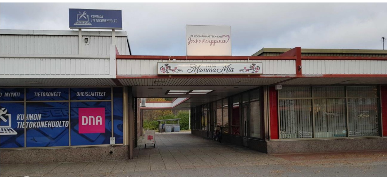
Kuva 57. Linja-autoaseman ja päivittäistavara-kaupan rakennuksia yhdistää toisiinsa yhtenäisenä koko rakennuksen mitan jatkuva katos. Liiketilöiden avoimet lasiseinät on paikoin peitetty teippauksilla.
